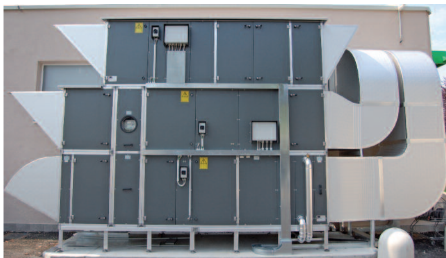
UTA con recuperatore di calore entalpico rotativo e con gruppo frigo. Serie ECOBLOC plus . Portata dell'aria 8400 m 3 /h
