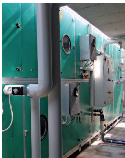
UTA con recuperatore di calore a flussi incrociati e con pompa di calore. Serie ECOPOOL. Portata dell'aria 25 000 m 3 /h
